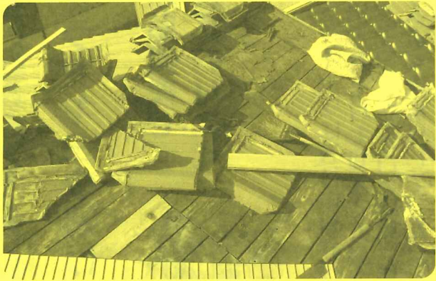
屋根を解体中...
