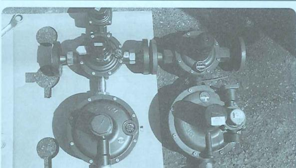
取り外した調整器(右側)と、新しく取付ける調整器です。
